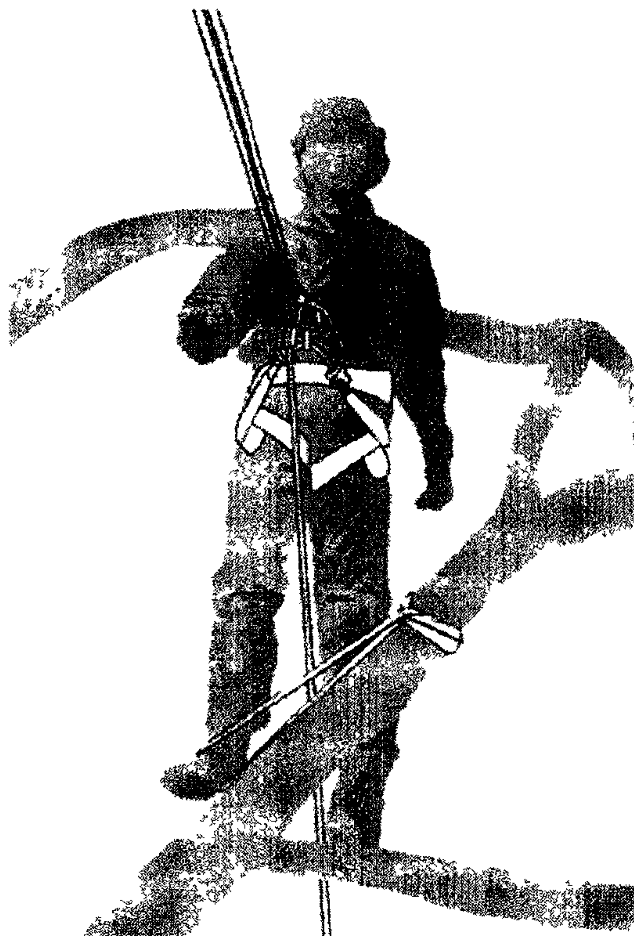
图 E. 4 用环索做临时马镫的示例
